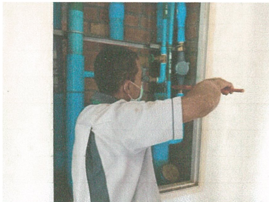
รูปภาพที่ 2.25 การตรวจสอบเส้นท่อจ่ายน้ำ
